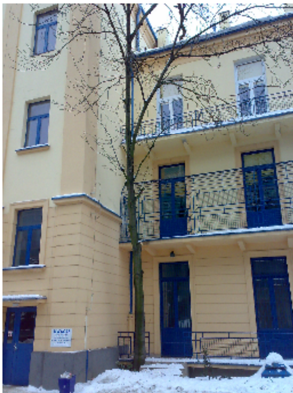
Fot. 7 i 8. Drzewa o wysokości przekraczającej 3 m pomiędzy drogą pożarową i ścianą budynku głównego A
