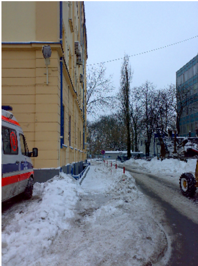
Fot. 4. Bliższa krawędź drogi pożarowej oddalona o 2,7 – 4,4 m od ściany budynku głównego A od strony zachodniej
