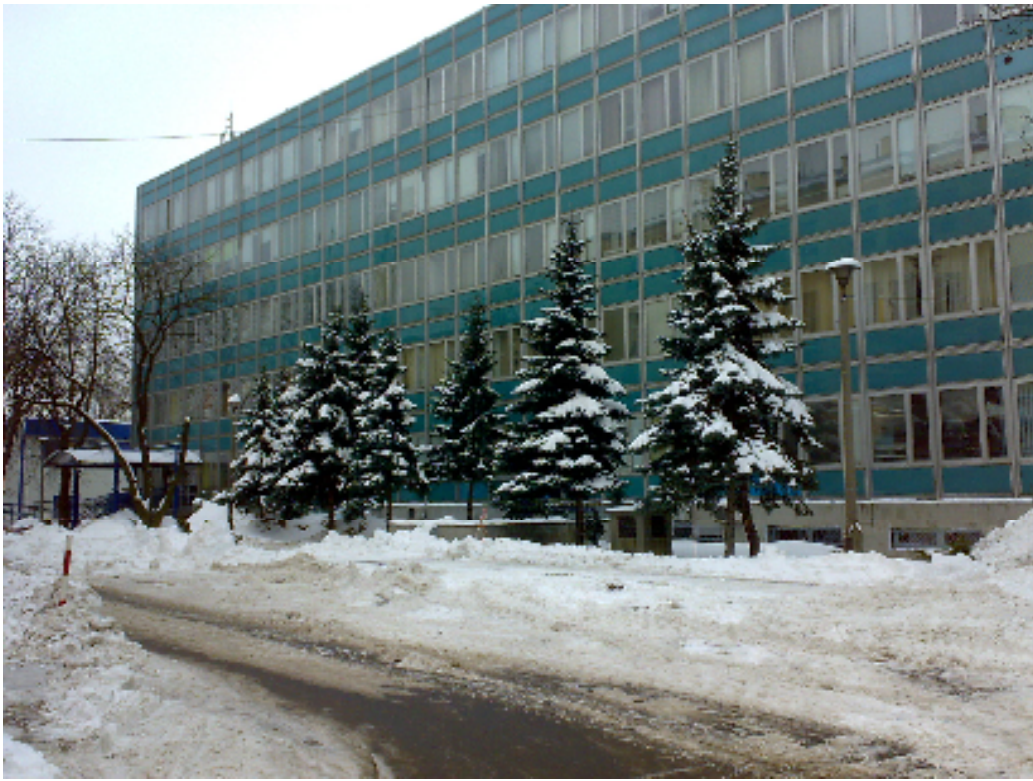
Fot. 5. Drzewa o wysokości przekraczającej 3 m pomiędzy drogą pożarową i ścianą budynku B typu „Lipsk”
