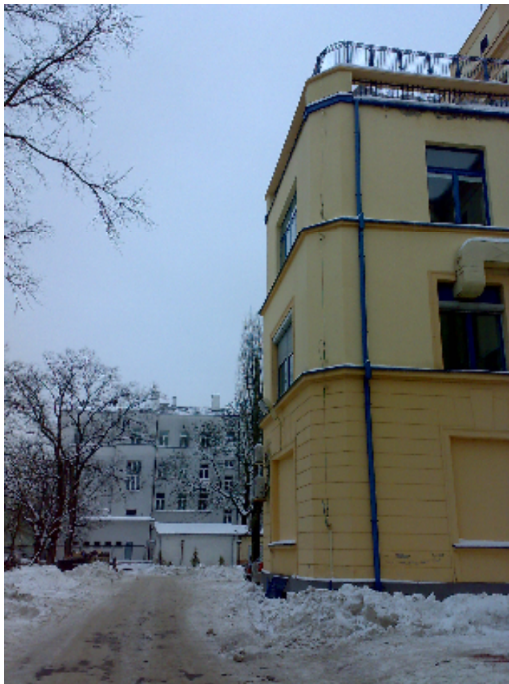
Fot. 3. Bliższa krawędź drogi pożarowej oddalona o 0,68 m od części ściany budynku głównego A na długości 17 m od strony północnej
