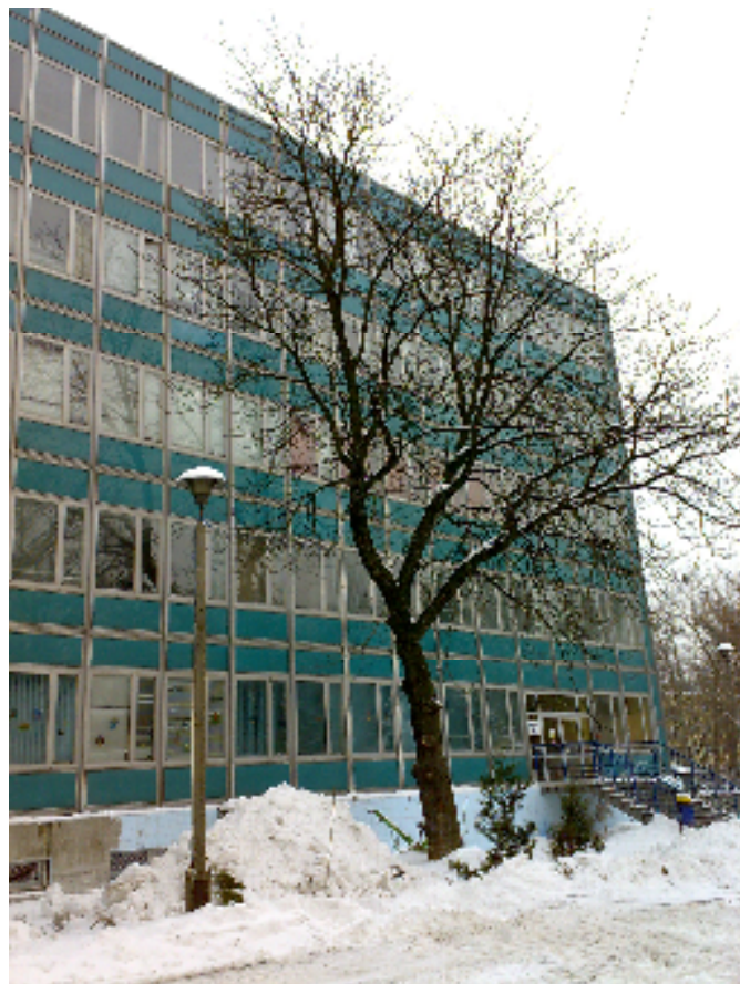
Fot. 6. Kasztan o wysokości przekraczającej 3 m pomiędzy drogą pożarową i ścianą budynku B typu „Lipsk”
